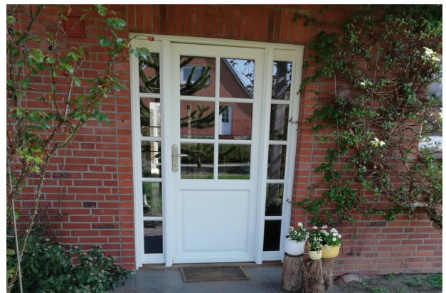
Überdachter Eingangsbereich mit neuer Haustür
