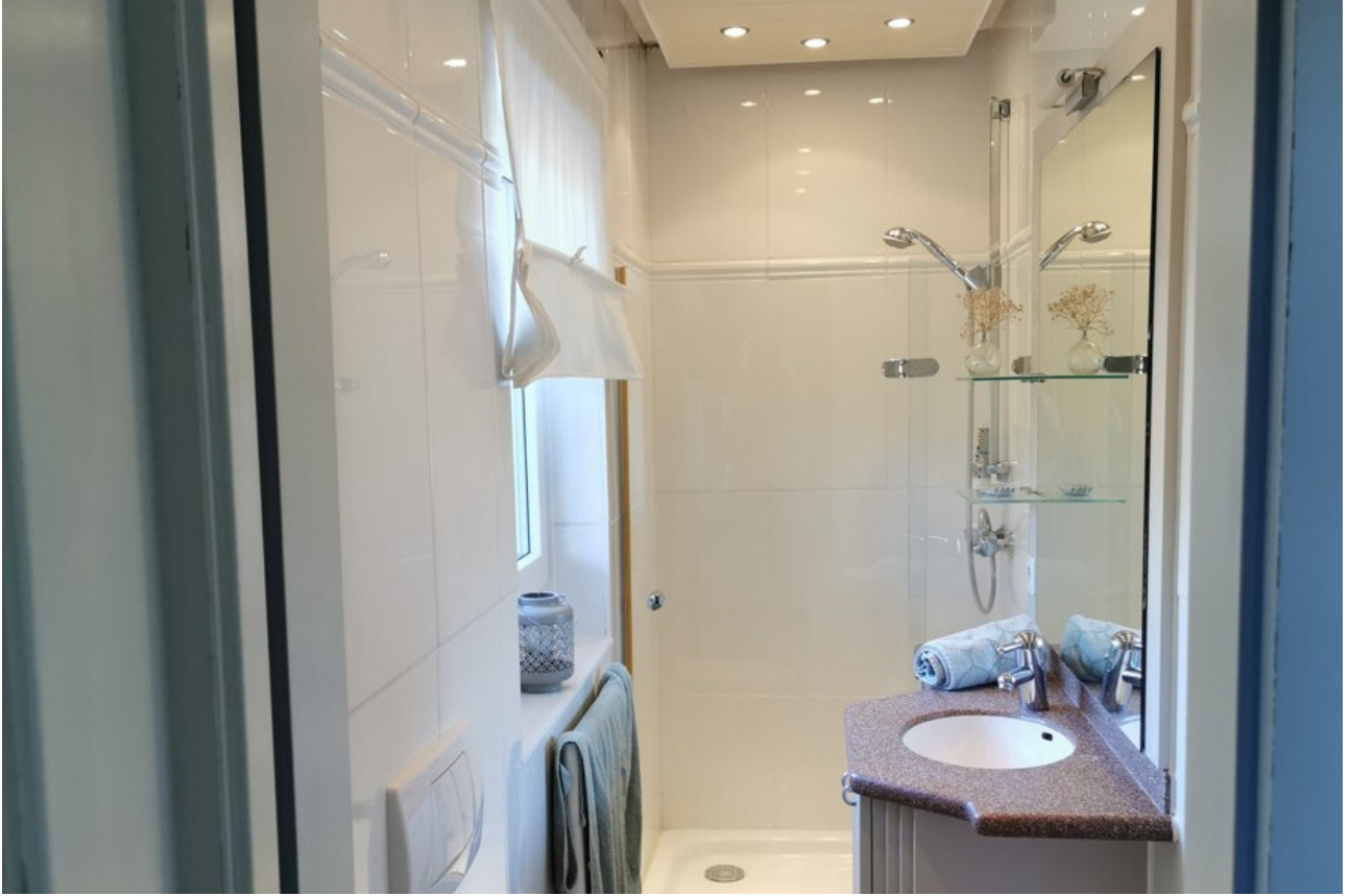
Erneueres Duschbad im Erdgeschoss
