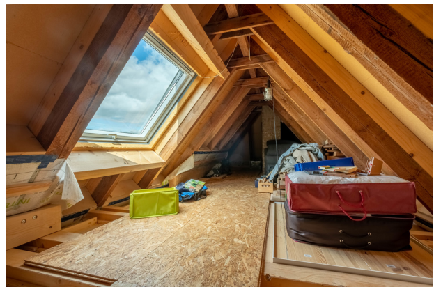
Dachboden mit großem Dachfenster
